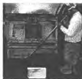
ภาพที่ 223 การเป่าแก้วให้เป็นกระเปาะ ของชิ้นงานขนาดใหญ่
