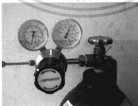
รูปที่ 4-14 การติดตั้ง Pressure regulator gage
