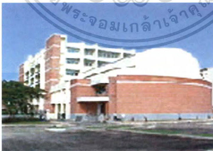
ภาพที่ 3.6 แสดงบริเวณภายนอกอาคารเรียนประถมศึกษา
