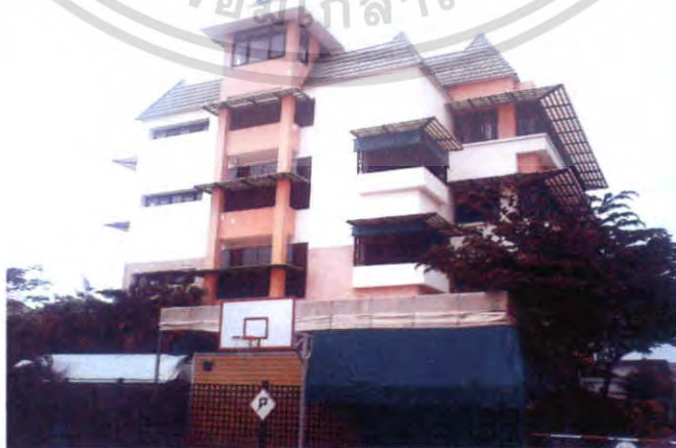
ภาพที่ 3.4 แสดงบริเวณภายนอกอาคารเรียนประถมศึกษา
