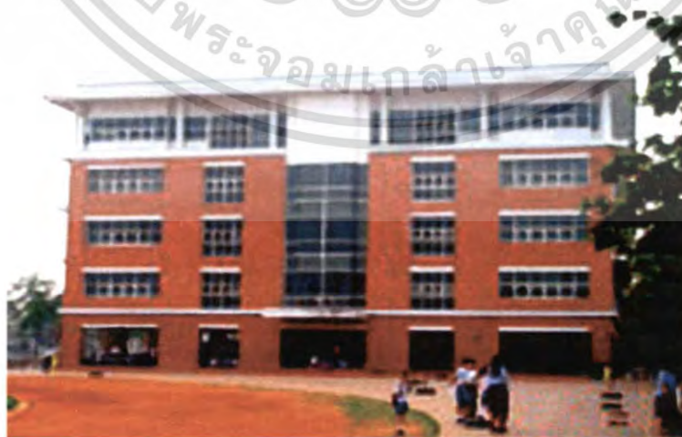
ภาพที่ 3.2 แสดงบริเวณภายนอกอาคารเรียนประถมศึกษา
