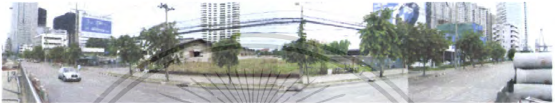
รูปที่ 5.4 / 11 ภาพถ่ายแสดงมุมมองถนนด้านหน้าที่ตั้งโครงการที่ 1
