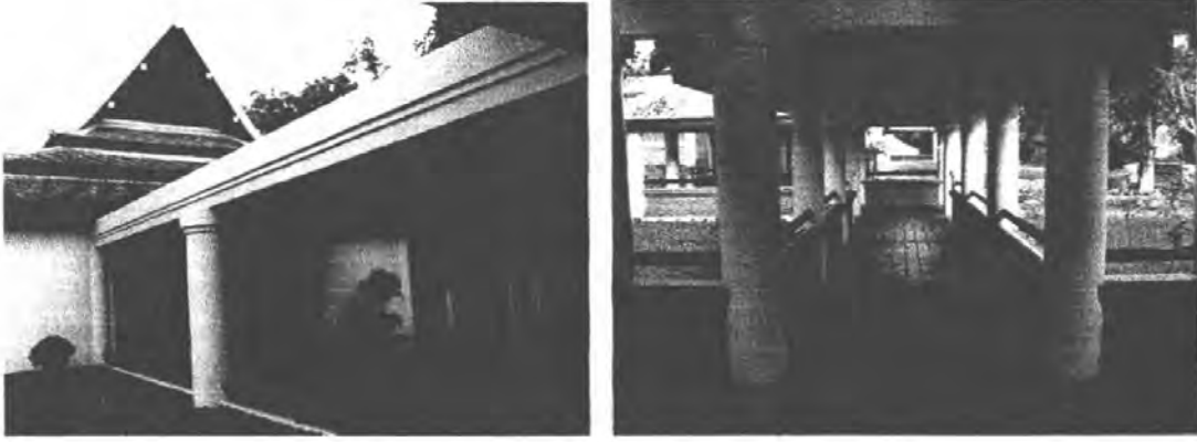
รูปภาพ 3.2.2-3 แสดงลักษณะทางเดินเชื่อมระหว่างอาคาร
