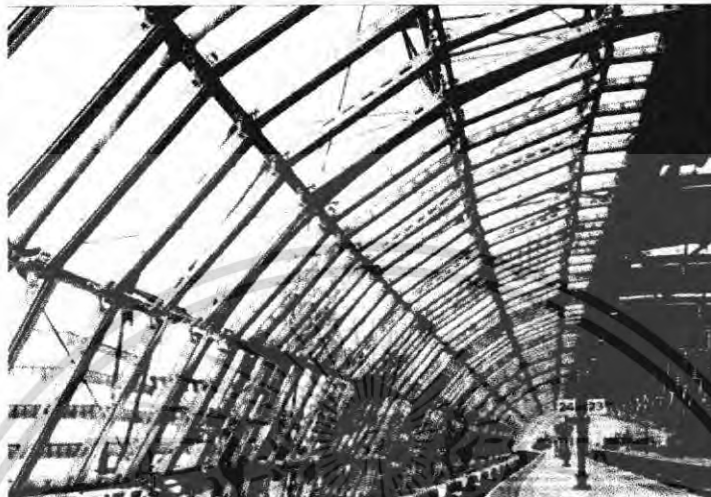
รูปที่ 4.25 รูปแสดง หลังคาที่ยกสูงขึ้นทางด้านทิศตะวันตกช่วยเปิดมุมมอง และช่วยให้เกิดแสง ธรรมชาติให้ สามารถส่องผ่านเข้ามายังชั้น platform ได้
