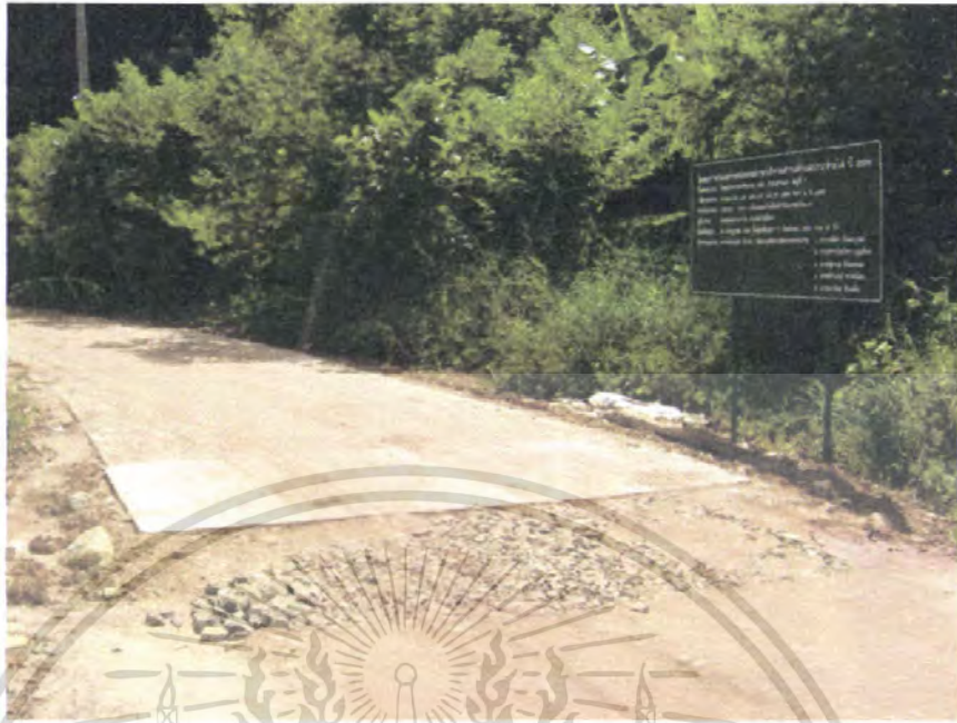
รูปที่ 6.27 สภาพถนนย่อยที่แยกจากถนนหลักเพื่อเข้าสู่ที่ตั้งโครงการ C
