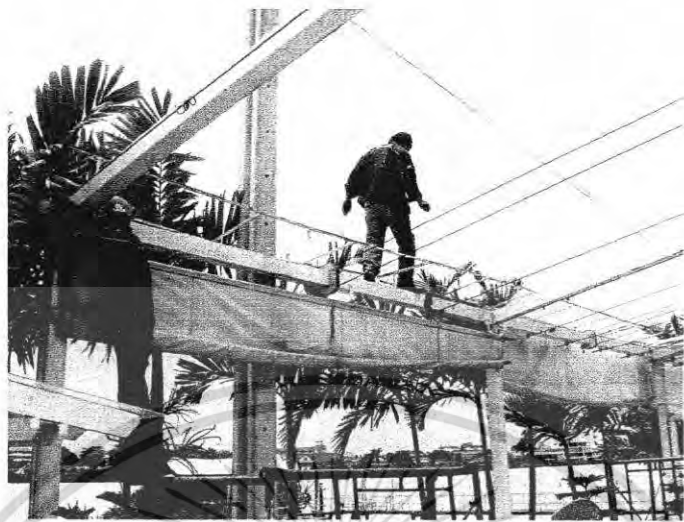
ภาพที่50. แสดงการซ่อมบำรุงผ้าใบกันฝนของไนโซน 5 ของสาขาเพียร์ 92
