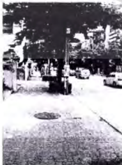
รูปที่ 79 : ลักษณะบนบาทวิถี
