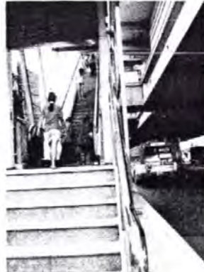
รูปที่ 84 : บันไดทางขึ้นสถานี
