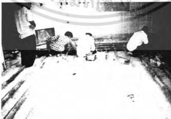
ภาพที่ 3.71 การทำให้พื้นเป็นสื่อไฟฟ้าลงดิน โดยต่อลวดทองแดงลงดิน หรือใส่ตะแกรงทองแดงลงไปในพื้นที่
