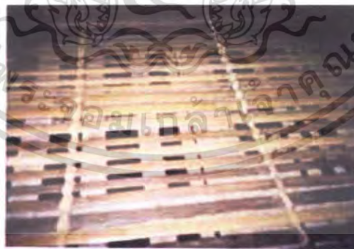
ภาพที่ 4.73 แสดงลักษณะฟากปูพื้นที่ทำจากไม้ไผ่
