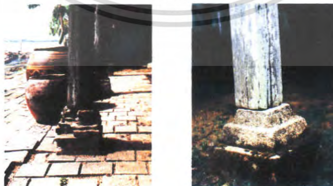
ภาพที่ 4. 88 แสดงเสาตอหม้อและการรองรับเสาในลักษณะต่างๆ
