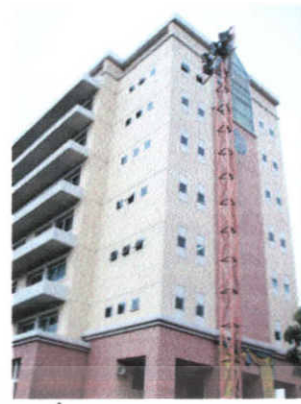
ภาพที่ 1.4 รูปแบบตัวอาคาร เป็นอาคาร 8 ชั้น
