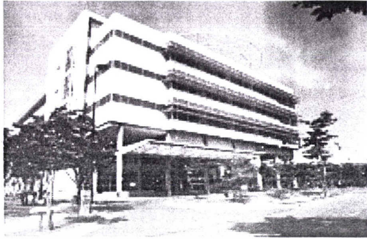
รูปที่ 45 แสดงทัศนียภาพภายนอกของอาคาร
