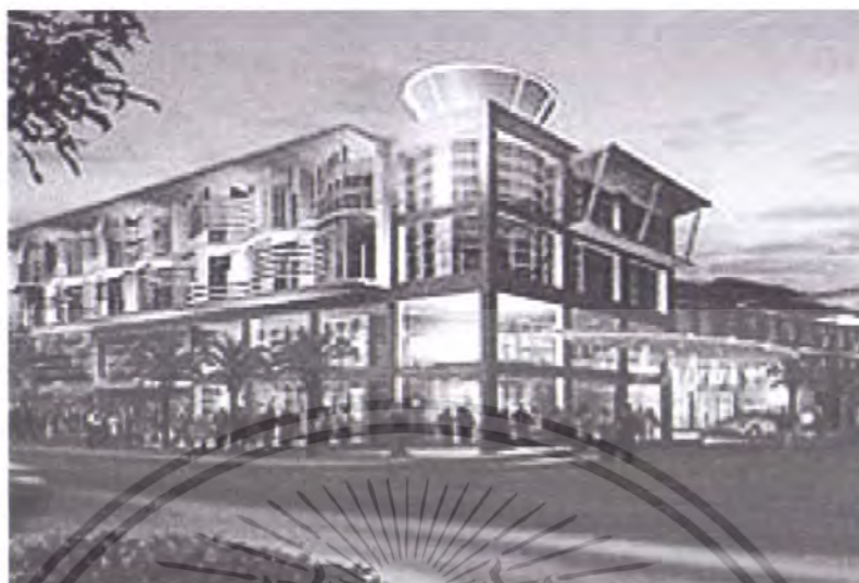
รูปที่ 2.27 แสดงทัศนียภาพภายนอกของตัวอาคาร Triple Two Silom Hotel
