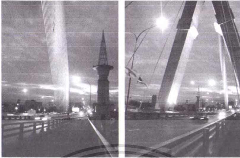
รูปที่ 5.29 ยามพลบค่ำในบริเวณสะพานพระราม 8 จะมีการเปิดไฟบริเวณสะพาน ทำให้เกิดทัศนียภาพที่สวยงามในยามค่ำคืน
