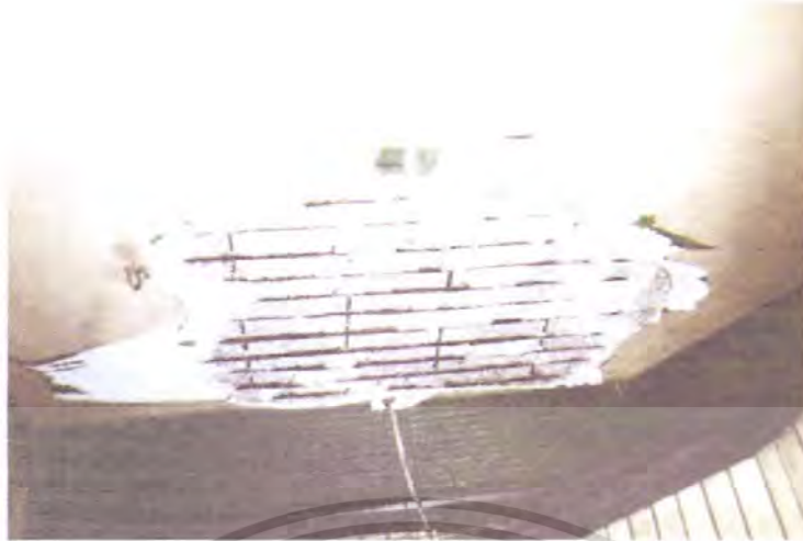
รูปที่ 2.3 แสดงคอนกรีตกะเทาะหลุดออกจากใต้ท้องพื้นจนเห็นเหล็กเสริมซึ่งส่วนใหญ่เป็นสนิม (ชเนศ วีระศิริ, 2548)
