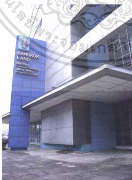
ภาพที่ 3.14 อาคารสำนักงาน
