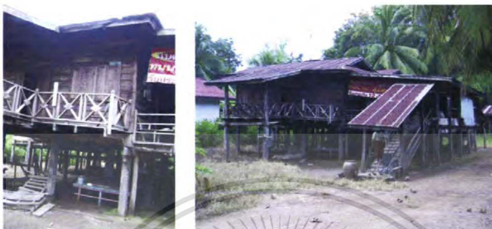
ภาพที่ 4.8 แสดงยกใต้ถุนสูง เจาะช่องเปิดน้อยมีลักษณะ 4 ช่วงเส้า 1 ช่วงเปิด
