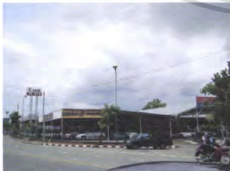
รูปที่ 5.20 อาคารฝั่งตรงข้ามที่ตั้ง
