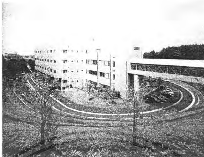
ภาพที่ 3.12 แสดงมุมมองภายนอกทางด้านทิศตะวันตกของอาคารกลาง
