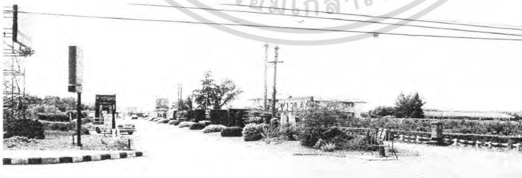
ภาพที่ 5.12 แสดงถนนทางเข้าโครงการที่ 2
