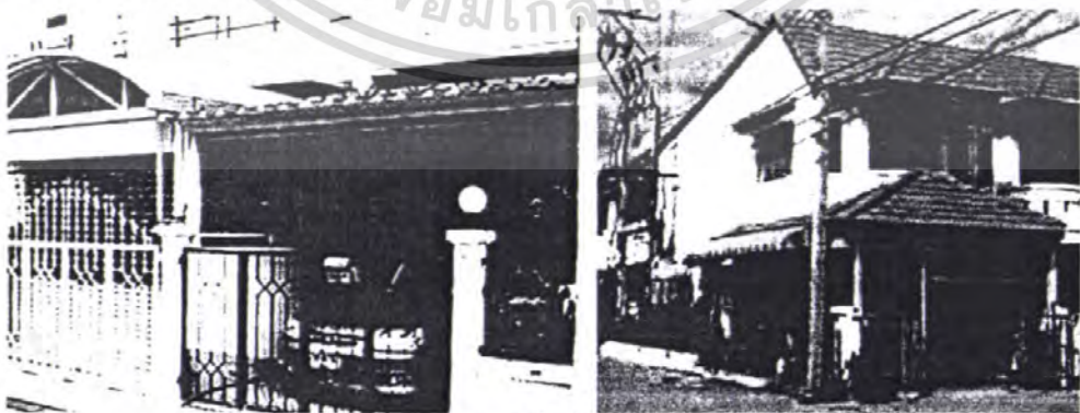
รูปที่ 2 : ภาพตัวอย่างการต่อเติมพื้นที่เพื่อใช้ประโยชน์ด้านอื่นๆ
