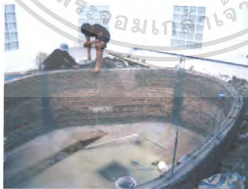
ภาพที่ 34 ผนังบ่อที่กำลังเตรียมเทพื้นหลัง
