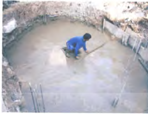
ภาพที่ 33 เทปูนแล้วทำการปาดให้ได้ระดับเตรียมก่อนฝังบ่อ
