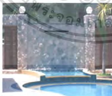
ภาพที่ 16 งาน หินภูเขา ตัดเคาะขอบปูซิดตกแต่งเป็น ผนังน้ำตก
