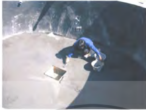
ภาพที่ 35 ฉาบขี้ตม้นลงฝุ่นดำที่พื้นและผนัง
