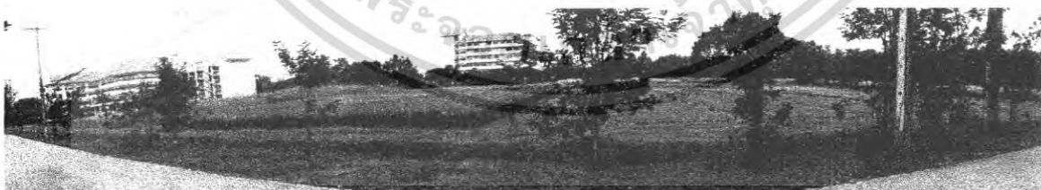
ภาพที่ 6.22 แสดงมุมมองออกจากโครงการทางด้านทิศเหนือ
