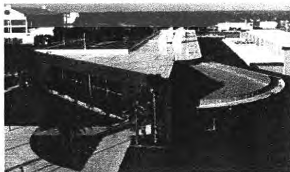
ภาพที่ 3.25 อาคาร Florida Solar Energy Center
