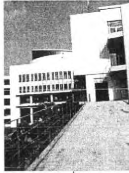
ภาพที่ 3.18 บริเวณทางเดินเชื่อมห้องสมุดกับอาคารเรียน ยื่นโครงสร้างบางเบาล้ำออกมาภายนอก
