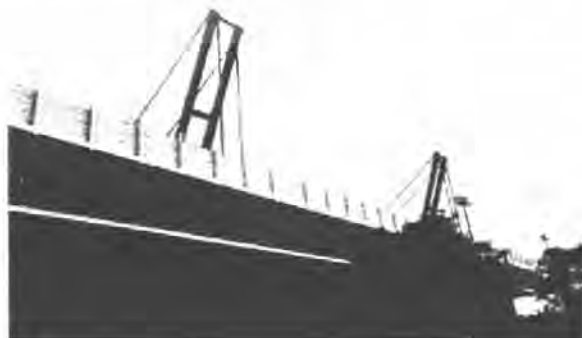
รูปที่ 5.14 ภาพการติดตั้งเคมิตส่วนหลังคาของ NSW State Sports Center
