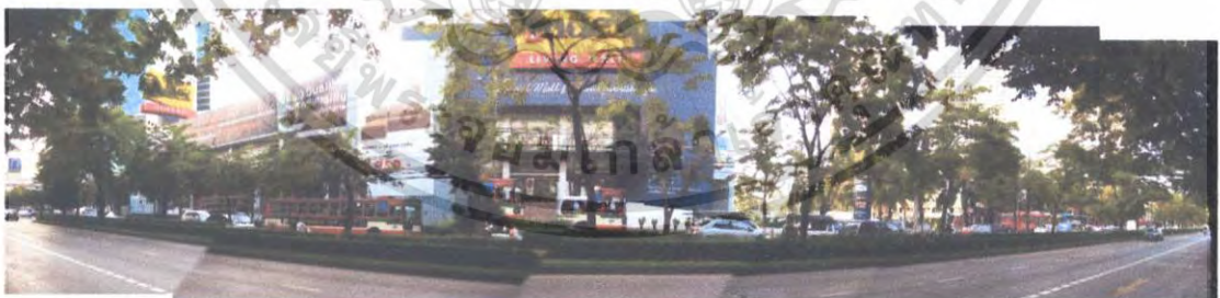
รูปที่ 4.22 แสดงภาพถ่ายที่ตั้งโครงการจากถนนฝั่งที่ตั้งโครงการไปยังฝั่งตรงข้ามโครงการ
