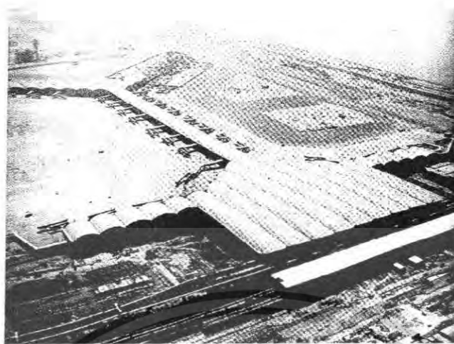
ภาพที่ 3.2.1-5 ทักษะสภาพภายนอกอาคาร ผังอาคารต้องการสื่อถึงรูปลักษณะเครื่องบิน
