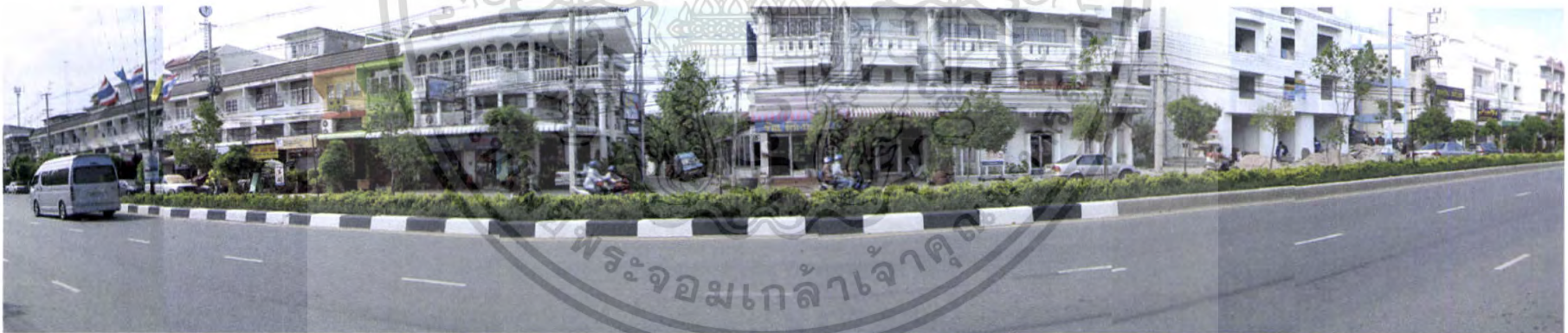
รูปที่ 4.9 ภาพถ่ายแสดงที่ตั้งถนนด้านหน้าโครงการ
