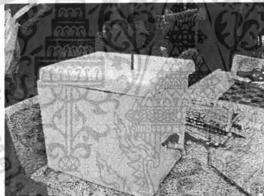
รูปที่ 3.6 ส่วนดักไขมันเดิมพร้อมฉนวนหุ้ม
