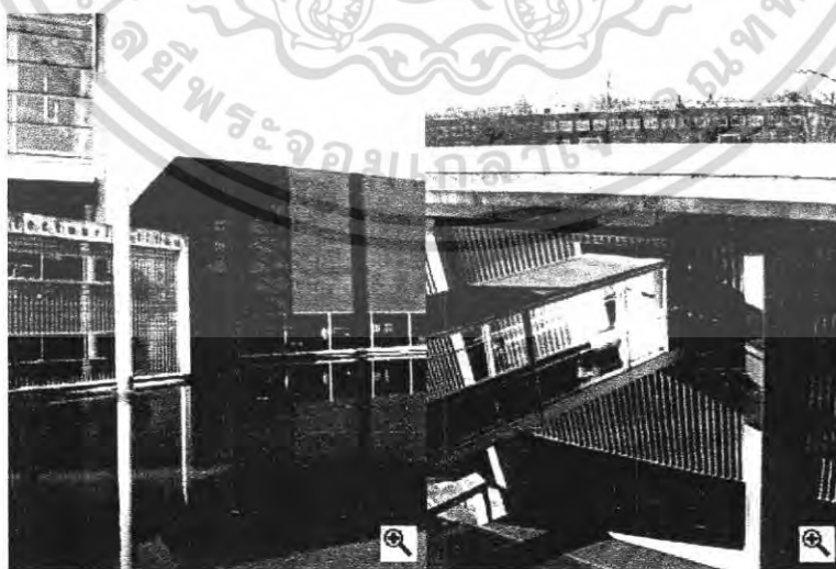
ภาพที่ 15 ซ้าย : แสดงให้เห็นถึงการไม่เชื่อมต่อของอาคาร ด้วยการ ใช้วัสดุที่แตกต่าง
