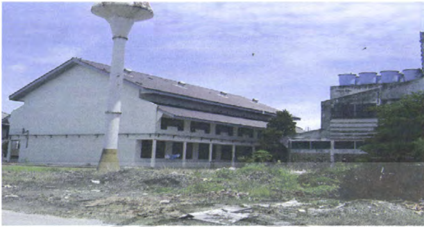
ภาพที่ 3.56 อาคารหล่อแบบ
