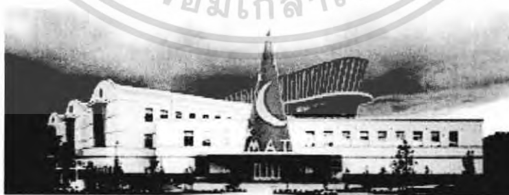
รูปที่ 3. 24 มุมมองภายนอกอาคาร
