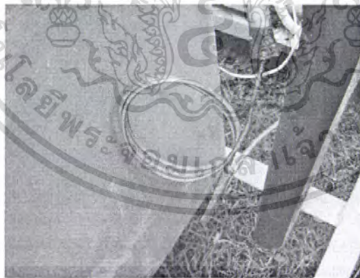
รูปที่ 3.19 Capillary tube ของชุดทำน้ำเย็น
