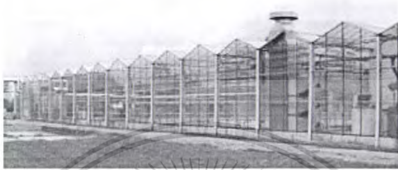
รูปที่ 2.8 โรงเรือนหลังคาต่อเนื่อง (Ridge and furrow)
