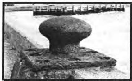
ภาพที่ 2.1 รูปแบบการกัดกร่อนทั่วผิวน้ำ
