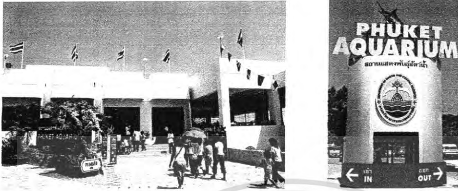
รูปที่ 3-25 แสดงทัศนียภาพภายนอกอาคาร
