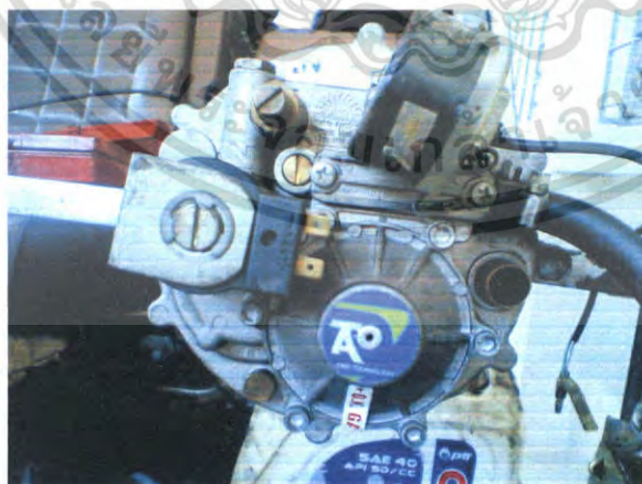
รูปที่ 4.1.13 แสดงภาพการติดตั้งมิกเซอร์
