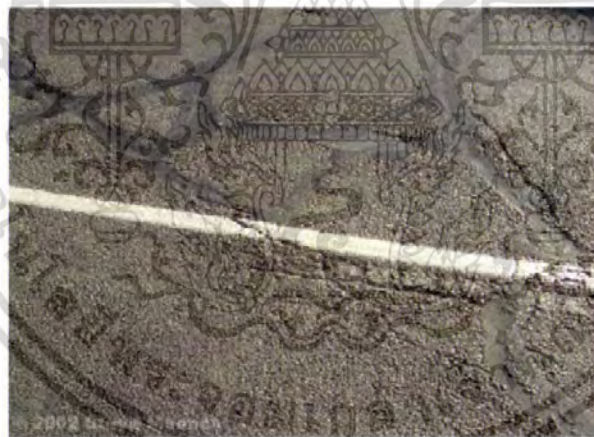
รูปที่ 1.2 สภาพการแตกร้าวของผิวทางถนนประเภทแอสฟัลต์ดิกคอนกรีต
