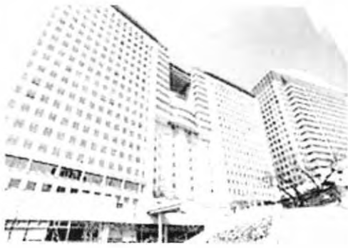
ภาพที่ 3.27 ทักษิณียาภายนอกและในอาคาร
