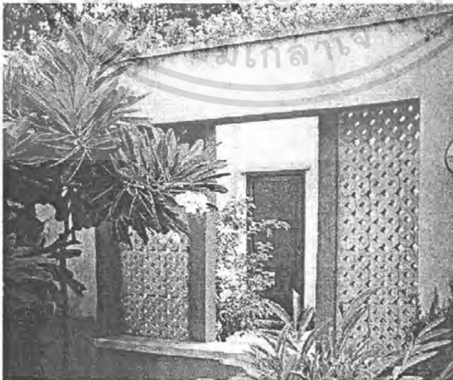
ภาพที่ 2.39 แสดง การก่อสร้างด้วยบล็อกคอนกรีต แบบปิดผิวและทำสี
