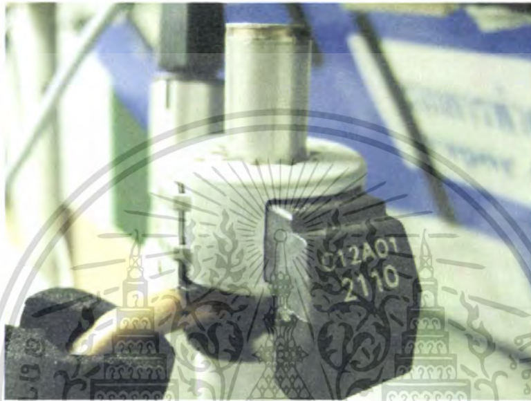
รูปที่ 3.4 แสดงวาล์วขยายชนิด Electronic Expansion Valve
