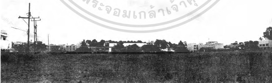
รูปที่ 3.42 ภาพแสดงด้านทิศใต้ที่ตั้ง SITE C
