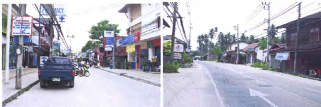
ภาพที่ 3.13 แสดงถนนคอนกรีตเสริมเหล็ก ในบริเวณพื้นที่ศึกษา
