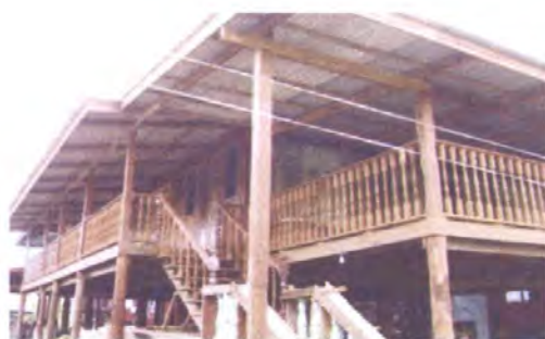
ภาพที่ 4.4 ลักษณะบ้านที่มีบันไดนอกตัวบ้าน
