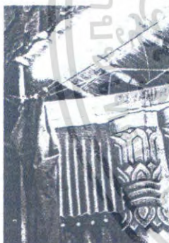
โครงฉากลูกคลื่น ทำด้วยไม้ไผ่กับลวด
