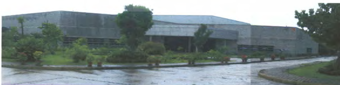
ภาพที่ 1.3 ภาพอาคารลักษณะทางเข้าด้านทิศตะวันออก
