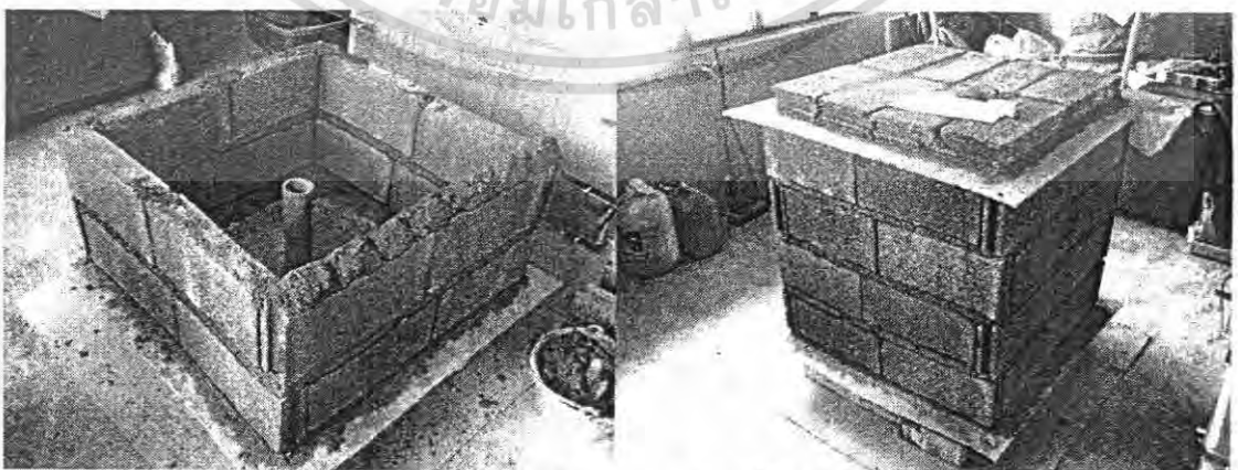
รูปที่ 3.38 การก่ออิฐบล็อกคอนกรีต เพื่อเตรียมการทดสอบ
