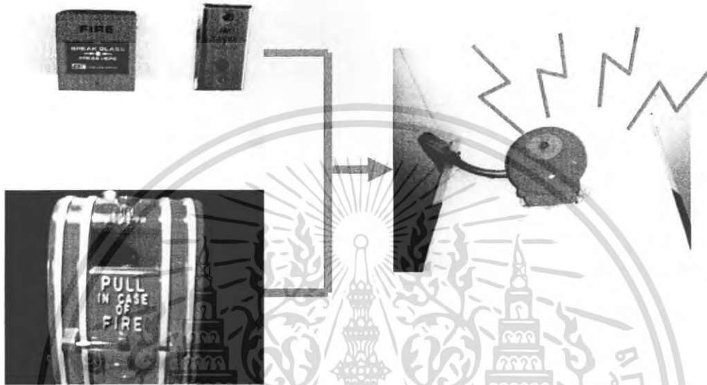
รูปที่ 6-5 แสดงขั้นตอนการทำงานของอุปกรณ์แจ้งเหตุเพลิงไหม้ด้วยมือกด หรือดึง
