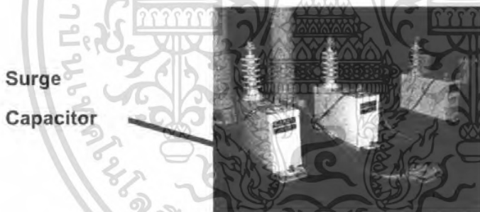
รูปที่ 3.7 Surge capacitor
