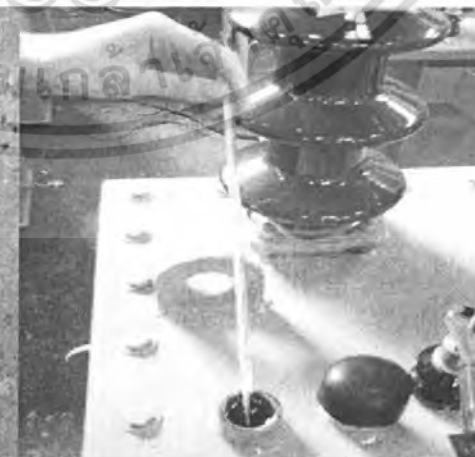
รูปที่ 3.7 วัดอุณหภูมิภายในหม้อแปลง
