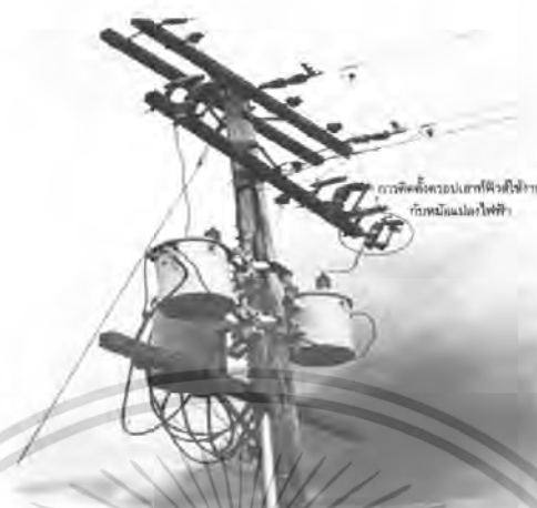
ภาพที่ 2.7 การติดตั้งครอบเอาต์ฟิวส์ที่ใช้งานในระบบไฟฟ้า
