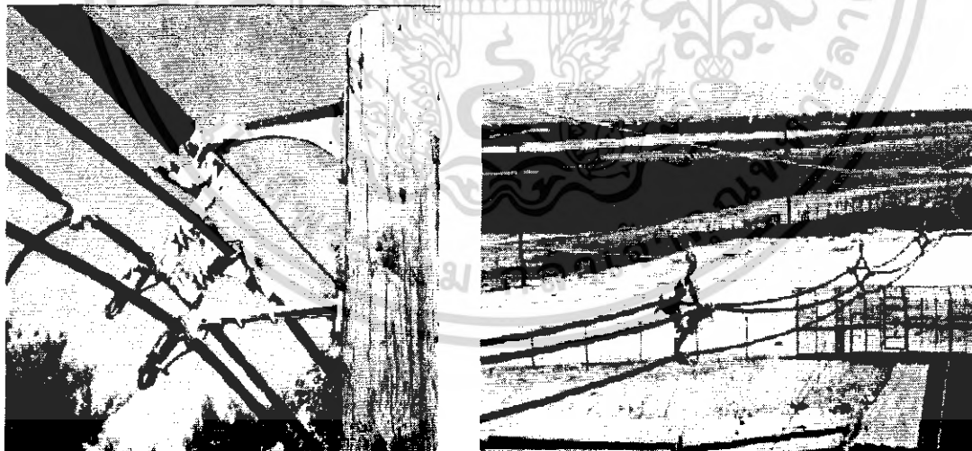
รูปที่ 2.19 การใช้งานเคเบิลสเปซเซอร์ในต่างประเทศที่ระดับแรงดัน 5 kV – 46 kV [7]
